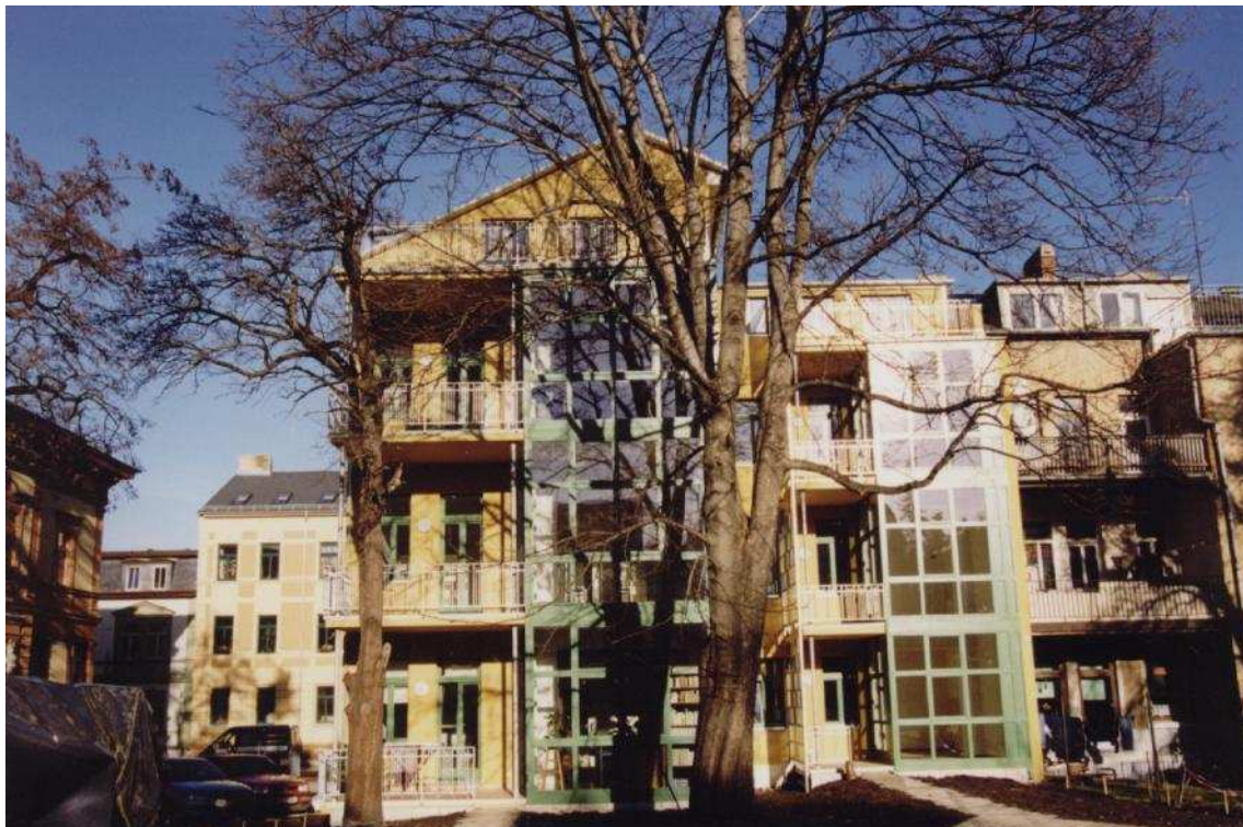
Umbau und Erweiterung Gründerzeithaus in Weimar Architekten: Roth und Zellmann Weimar
