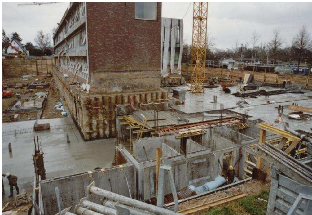
Umbau der ehem. Holländischen Botschaft zum Geschäftshaus mit Tiefgarage Architekt: Architekturbüro Piotrowski Bonn
