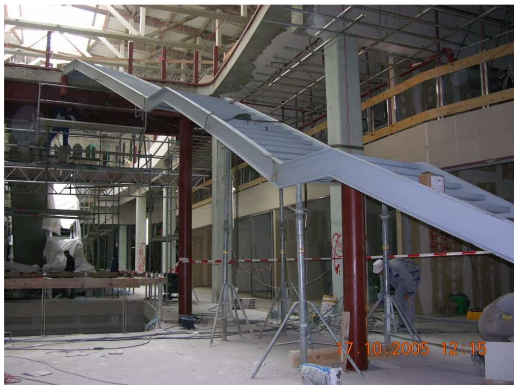
Umbau des ehemaligen Gauforums Weimar zur Shopping Mall Weimar Architekten: Saller Gewerbebau Weimar
