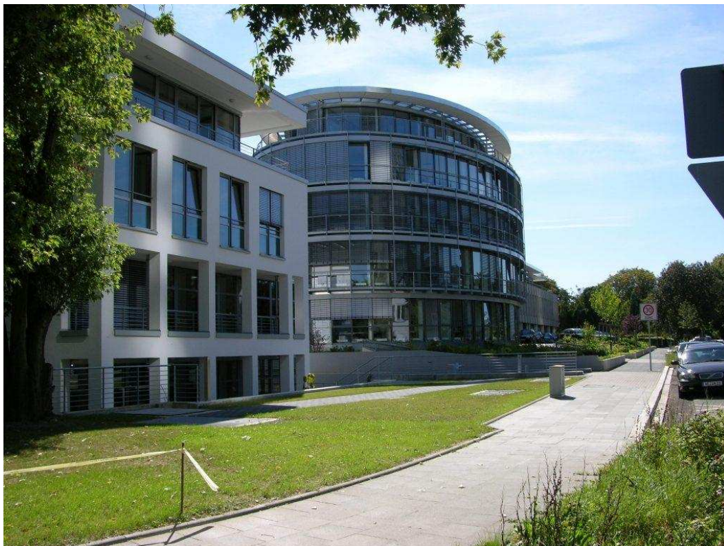
Umbau der ehem. Kanadischen Botschaft zum Geschäftshaus mit Tiefgarage Architekt: Architekturbüro Piotrowski Bonn
