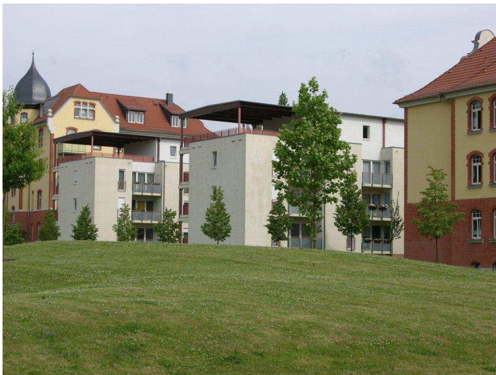
Umbau einer ehemaligen Kaserne zur Wohnanlage mit Tiefgarage Reußpark in Gera Architekten: Neufert-Mittmann-Graf Planungs-AG Köln
